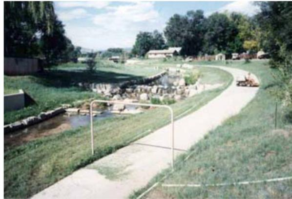
**Figura 29: Canal disipador de energía.**
