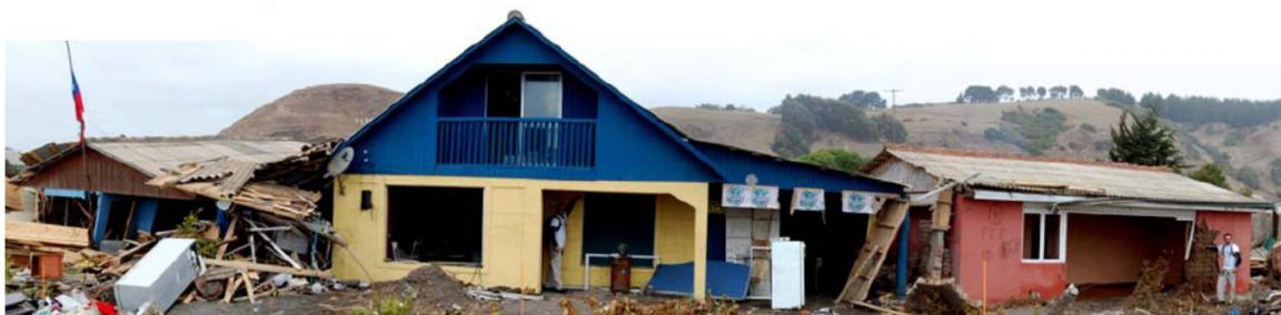
Figura 16: Diferentes fallas después del tsunami 27 Febrero 2010 en Iloca, Chile.
