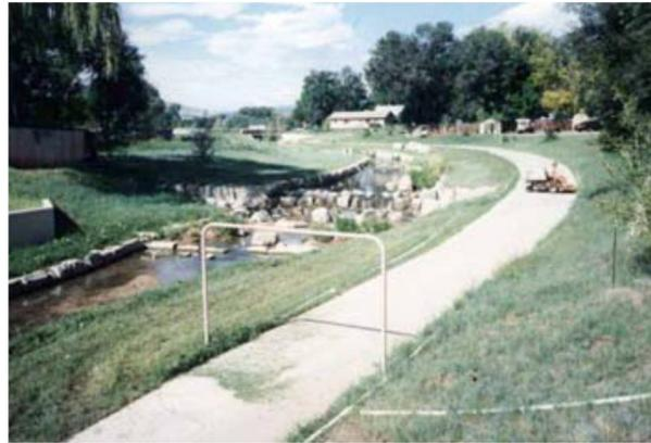
**Figura 29: Canal disipador de energía.**
