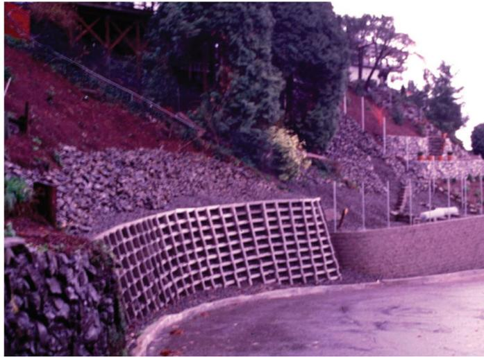
**Figura 37: Muro de contención.**
