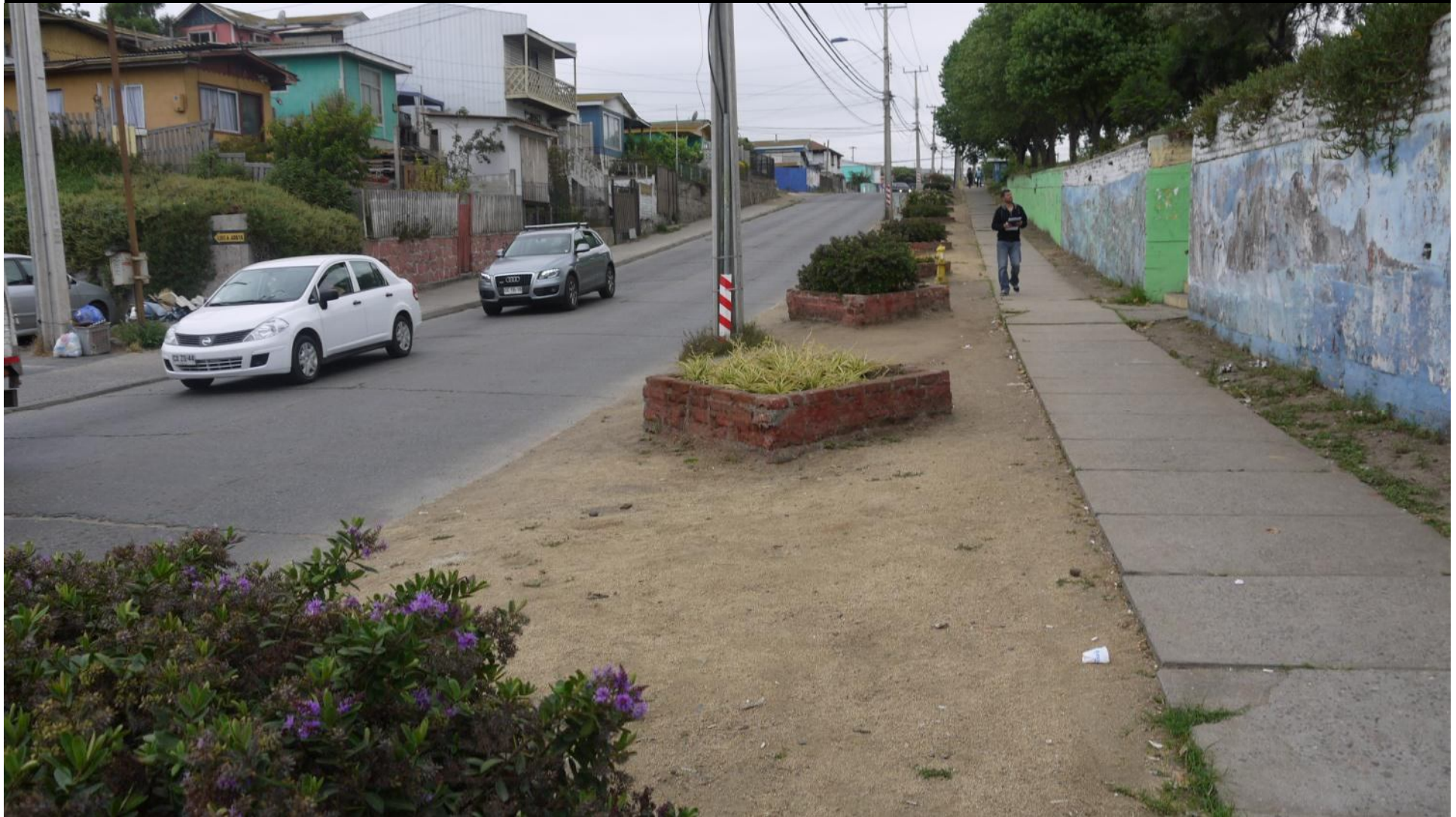
BANDEJÓN Y MURO DE CONTENCIÓN
